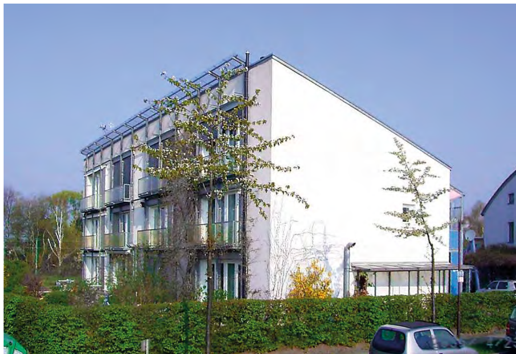
Dom pasywny w Darmstadt-Kranichstein, wybudowany już w 1991 rok, fot. Passivhaus Institut, CC BY-SA 3.0 < http://creativecommons.org/licenses/by-sa/3.0/ >, via Wikimedia Commons
