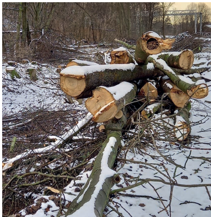
Masowa wycinka wzdłuż rewitalizowanej linii kolejowej Cieszyn–Goleszów. Tylko na tym 10-kilometrowym odcinku zniknie ponad 1200 drzew, a wiele z nich mogłoby rosnąć dalej, nie przeszkadzając w realizacji inwestycji i w niczym nie zagrażając przejeżdżającym pociągom. Fot. J. Brzeżycki
