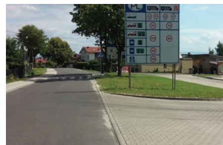
Droga po przebudowie. Fot. Renata Owczarzy
