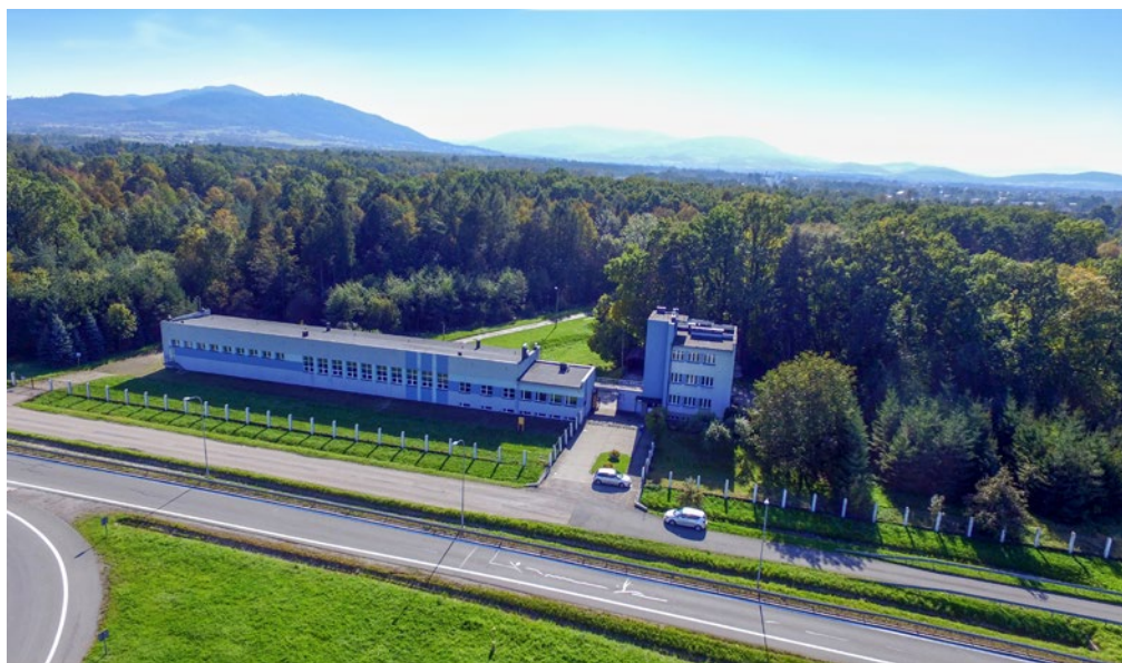
Stacja Uzdatniania Wody w Pogórze. Fot. Archiwum: Wodociągi Ziemi Cieszyńskiej Sp. z o.o.
